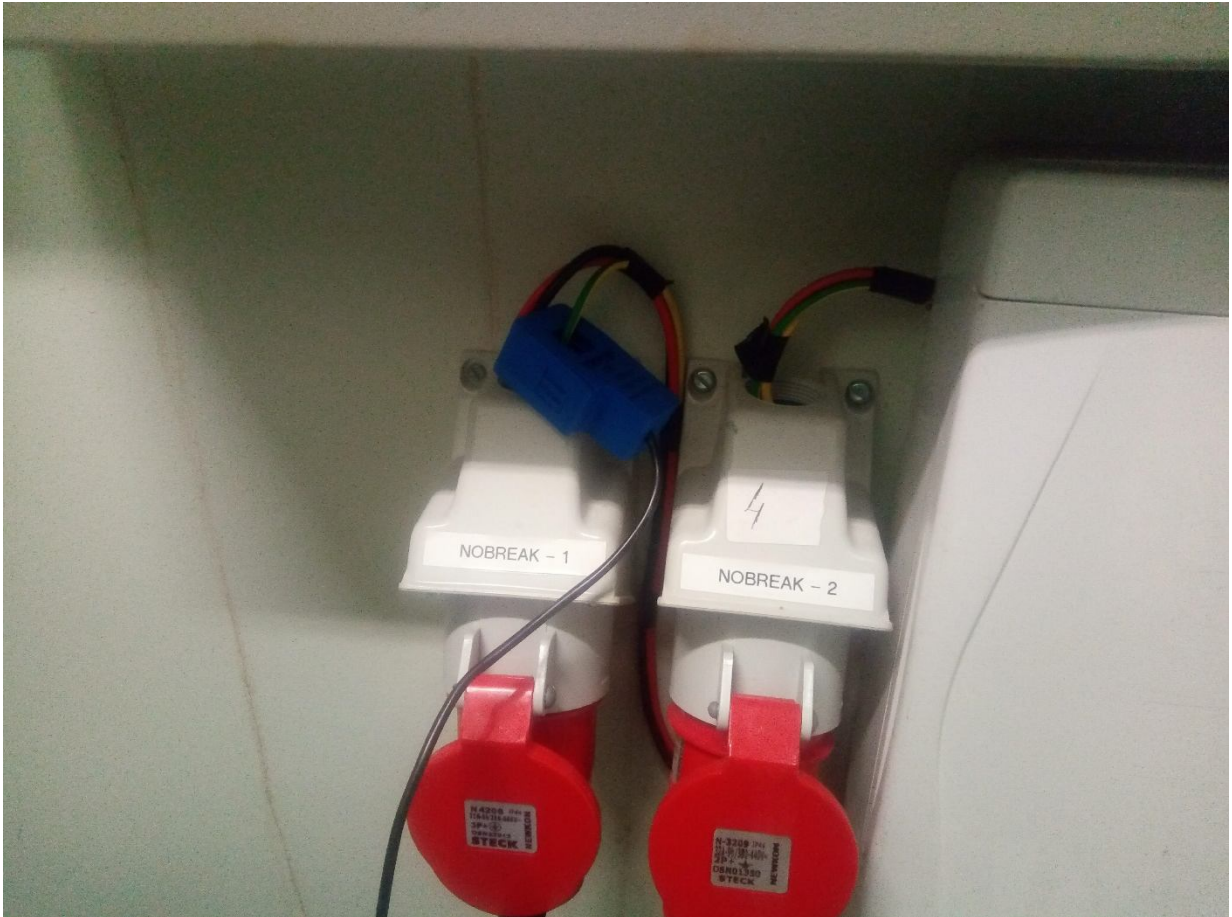
Figura 80: Tomada que o nobreak está ligado.
