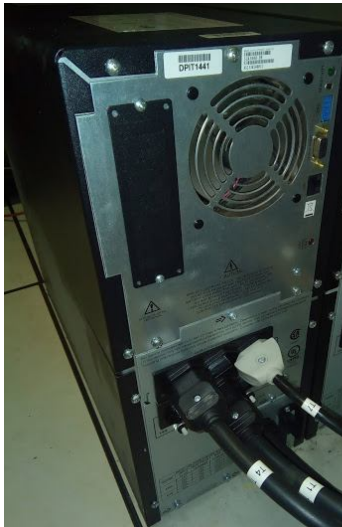
Figura 79: Tomada dos servidores.
