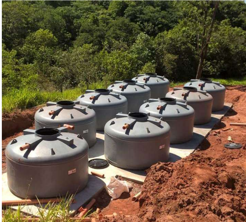
Figura 7 - Tanques dispostos sobre a base radier
