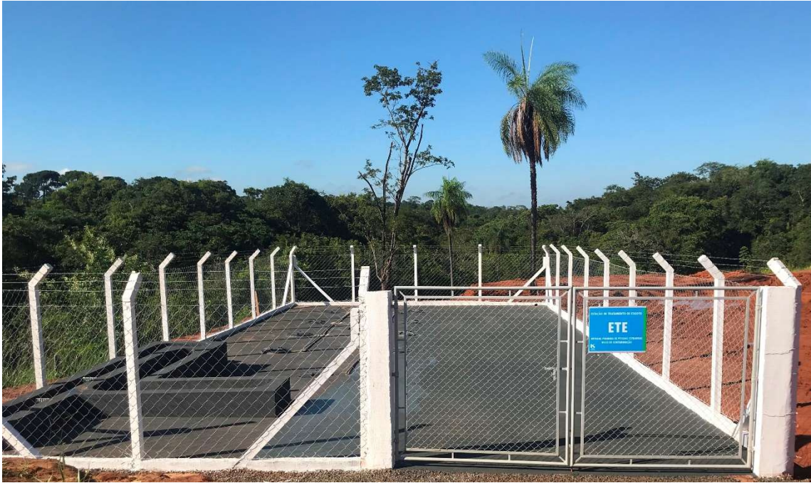
Figura 10 - Implantação da ECTE finalizada.
