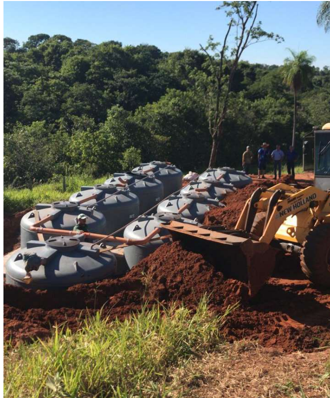
Figura 9 - Tanques sendo recobertos.
