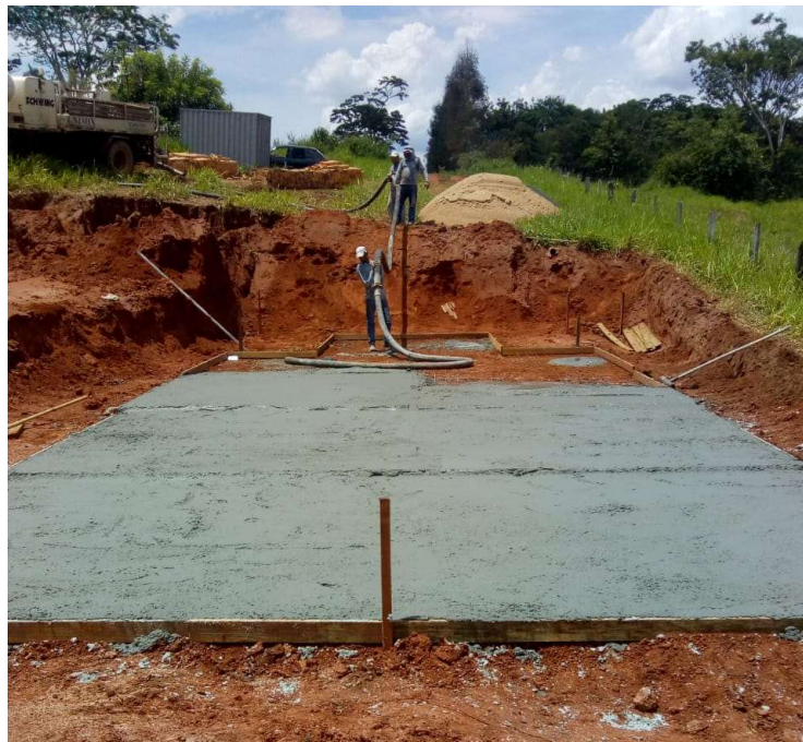
Figura 6 - Construção da base para a disposição dos tanques da ECTE
