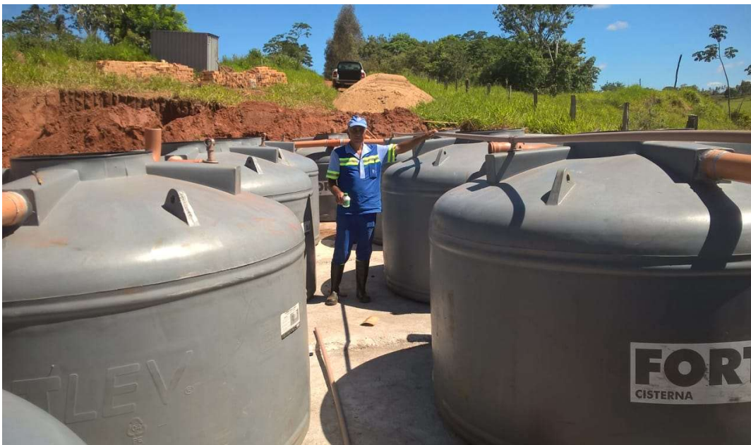
Figura 8 - Instalação dos tanques e sistemas hidráulicos.
