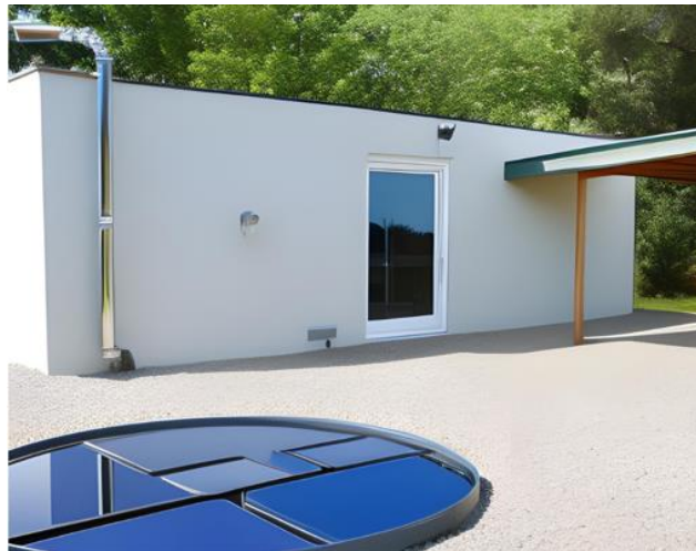
Figura 2 – Sistema de captação da água do telhado
