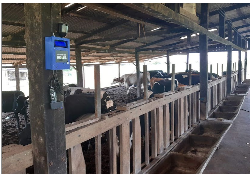
Figura 15 - Teste do equipamento desenvolvido no galpão de descanso.
