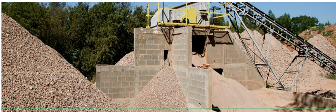
Figura 15: Usina de reciclagem de entulho. Fonte: Mejan – 2016
