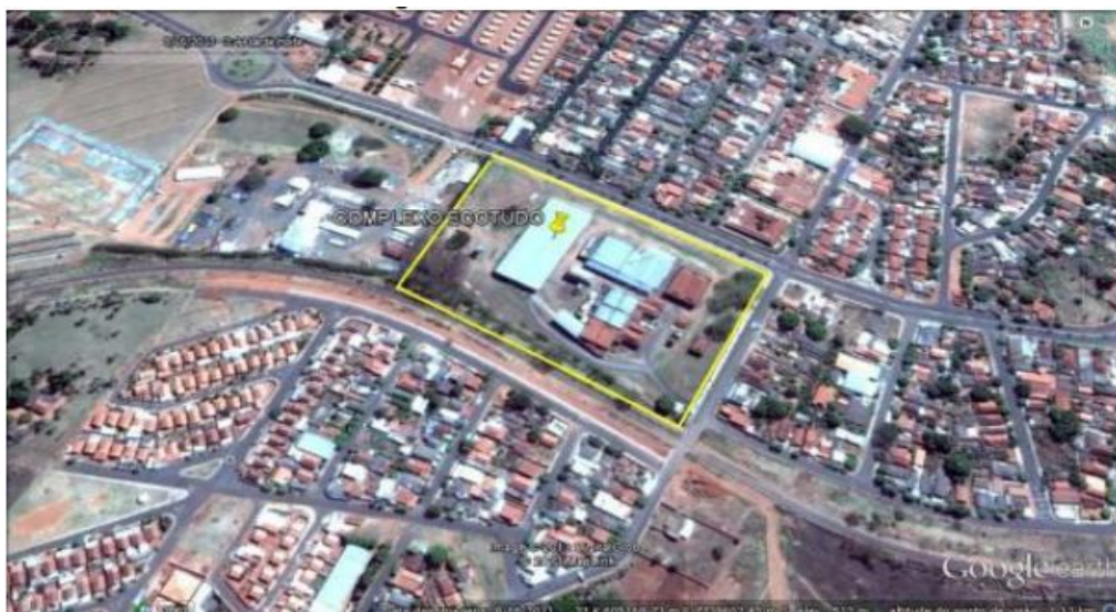
Figura 9: Vista aérea – Ecotudo Zona Sul.
