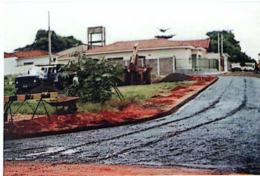
Asfaltamento da rua Euclides da Cunha.
