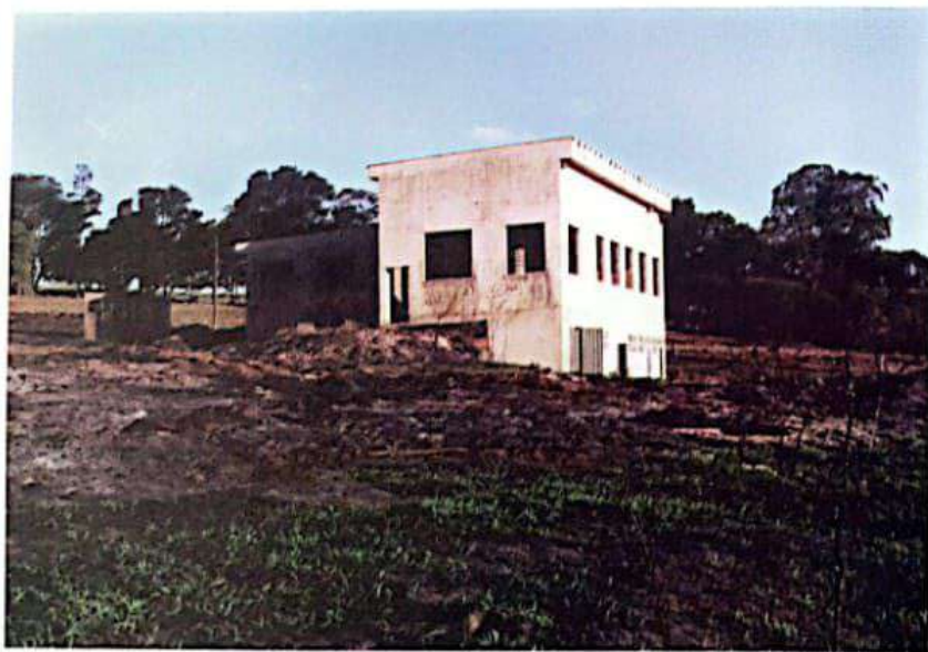
Construção do Matadouro Municipal.
