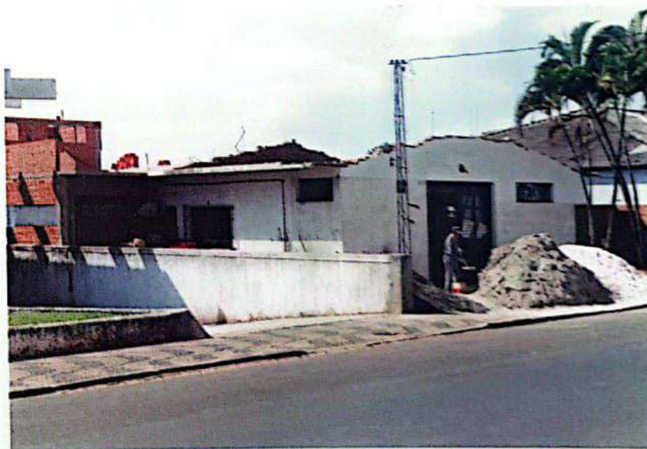
Reforma e ampliação do Prédio dos Correios.
