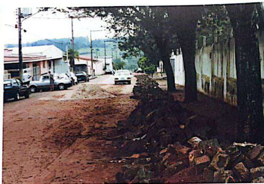
Substituição de adutoras - preocupação com a saúde.
