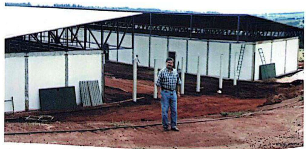
O prédio recebe cobertura.
