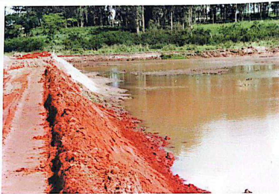
Início da construção da...
