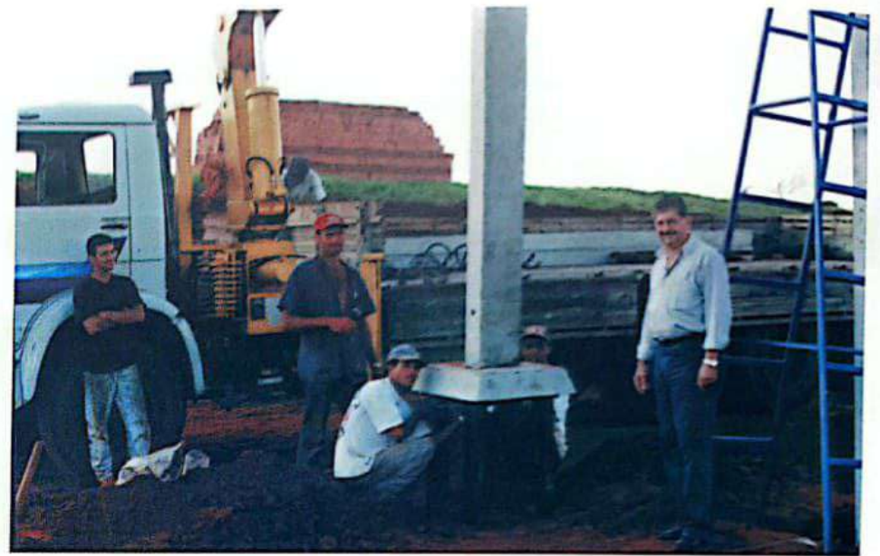
... o início da construção...
