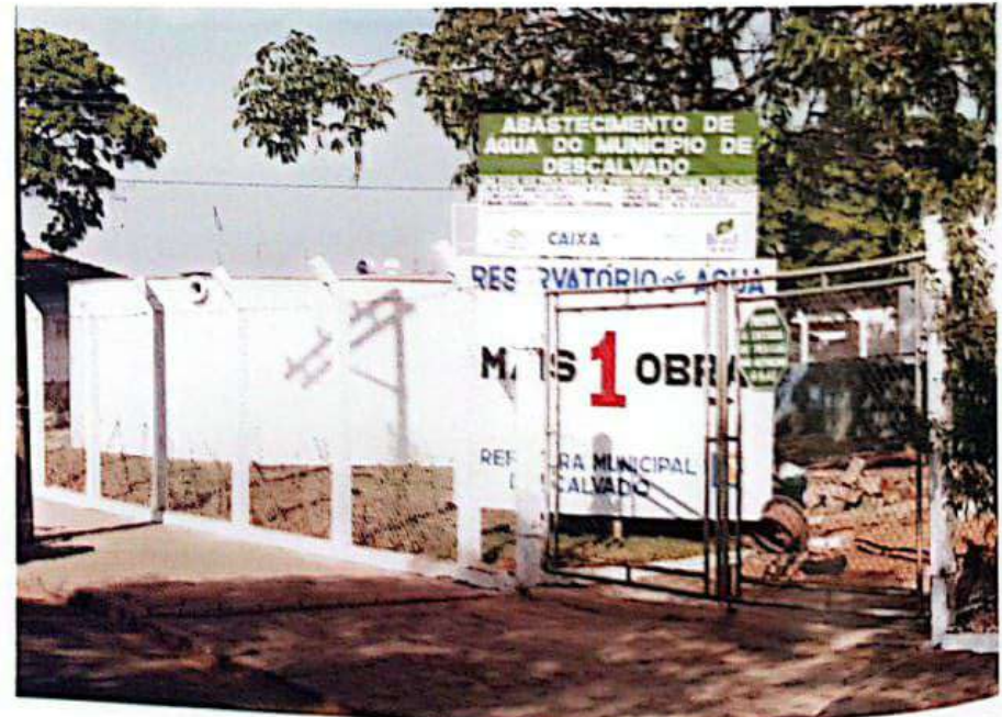
Reservatório de Água no Jardim Belém.
