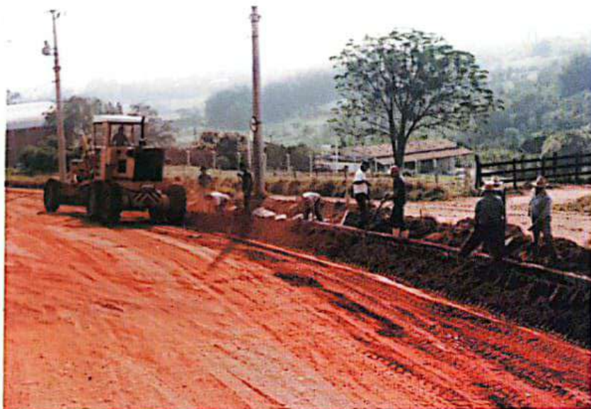
Asfaltamento da av. das Flores, no bairro Morada do Sol.
