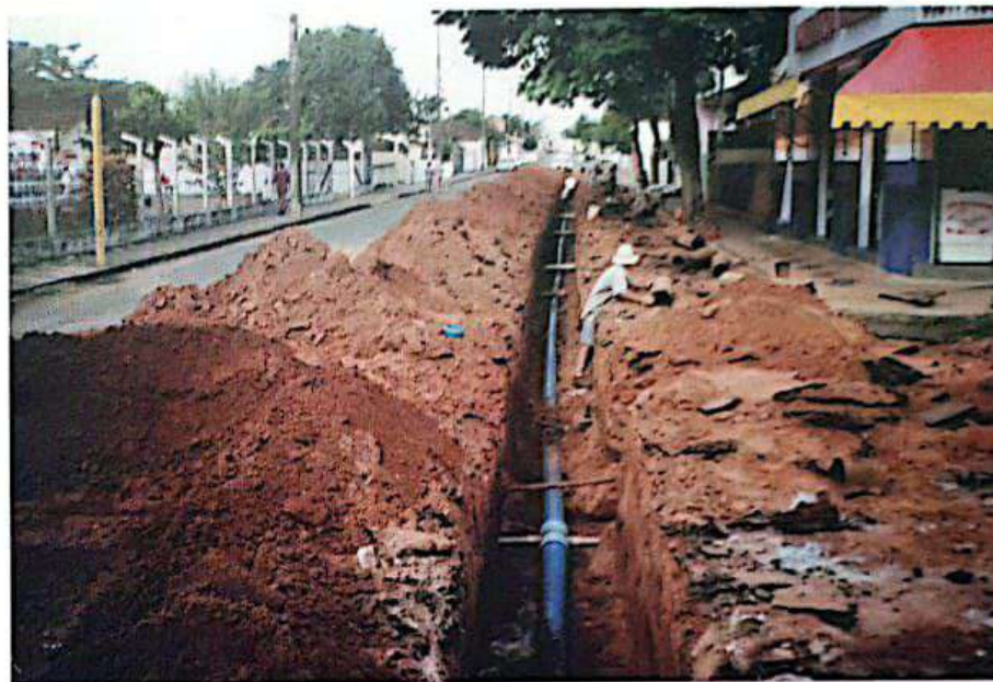
Foram 9 km de adutoras substituídas na cidade.
