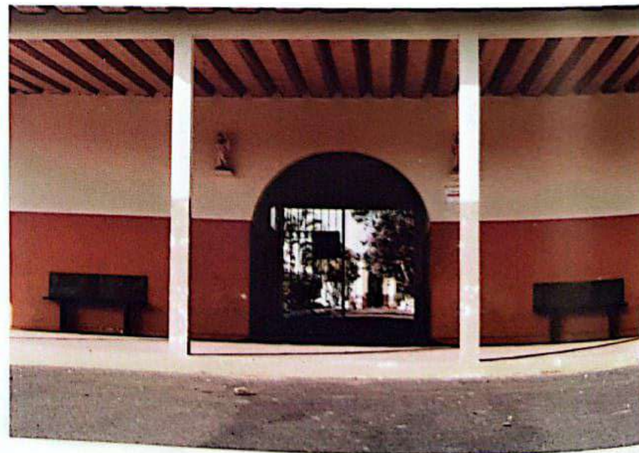
Reforma geral do Cemitério Municipal.
