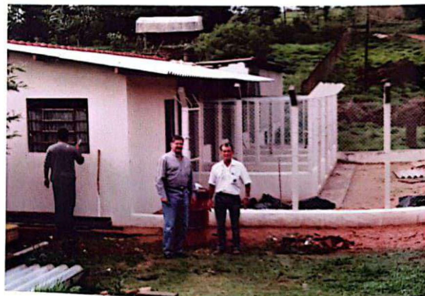
Construção do gatil; e recuperação do canil.
