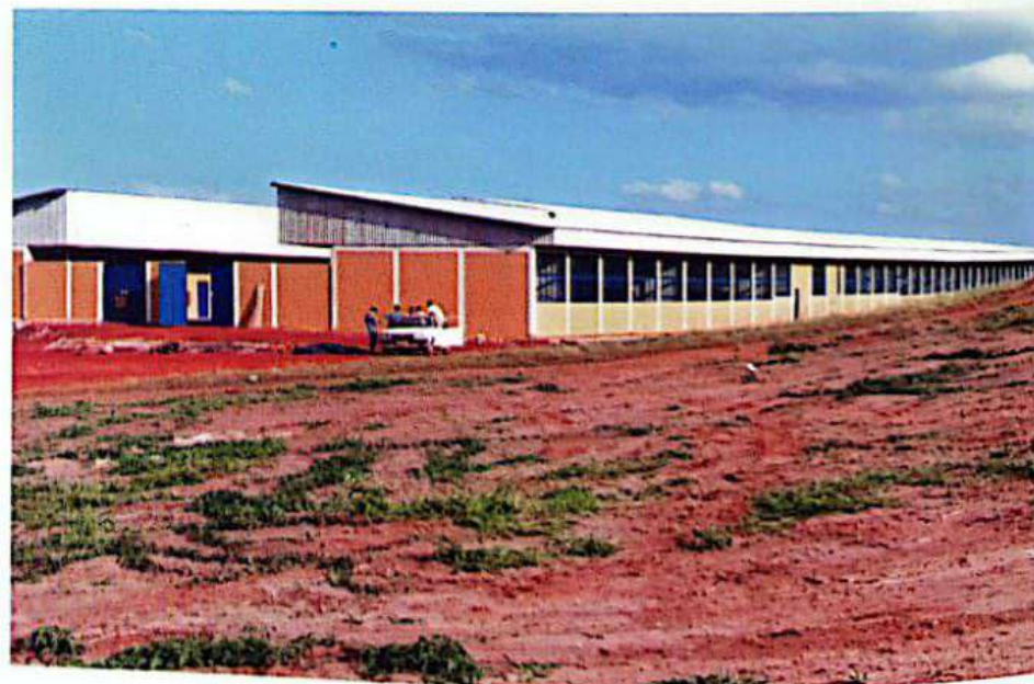
Nova vista parcial do prédio da Unicastelo.
