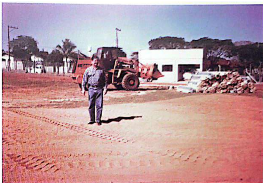
Construção do CLT Santa Cruz.
