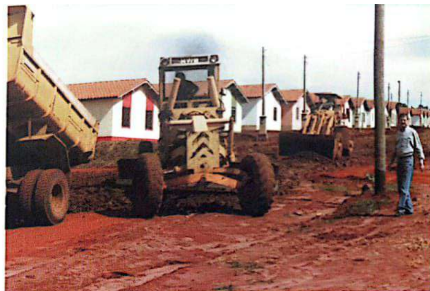
Infra-estrutura do bairro Morada do Sol.
