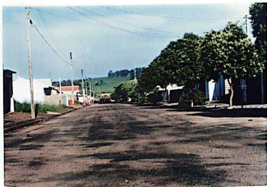
Asfaltamento das ruas do Jardim Cambará.
