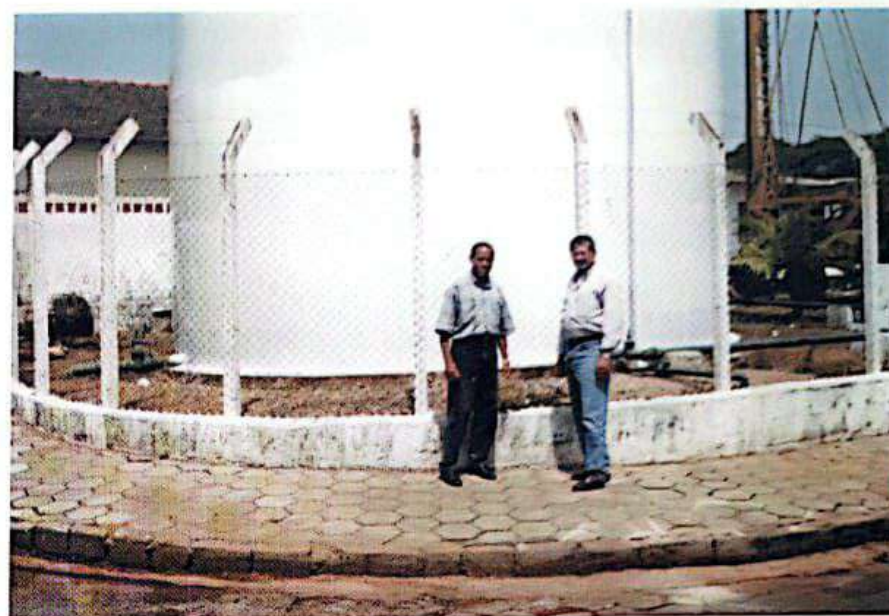
Reservatório de Água do bairro Santa Cruz.
