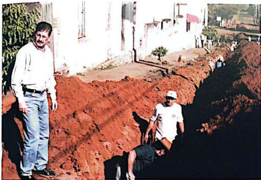
Obras enterradas - grande alcance na área da saúde.
