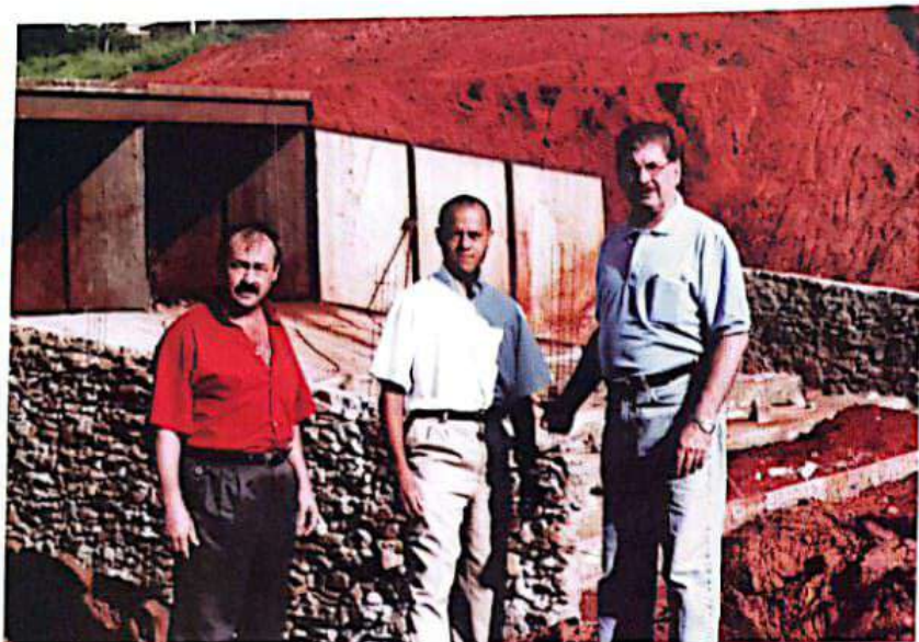
Construção de galerias na passagem do bairro Bela Vista.
