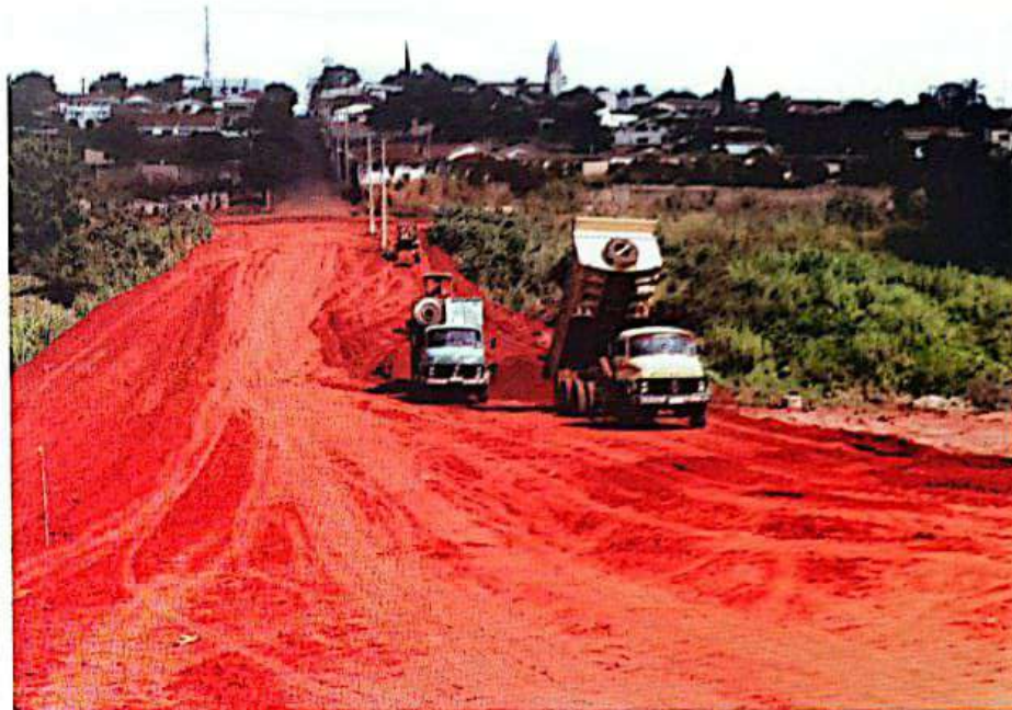
Passagem do Bela Vista: inteiramente recuperada.
