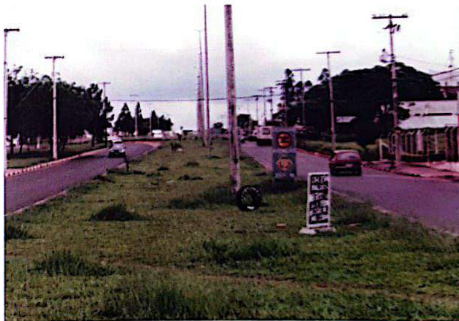
Substituição da iluminação alta da rua Cel. Arthur Whitacker.
