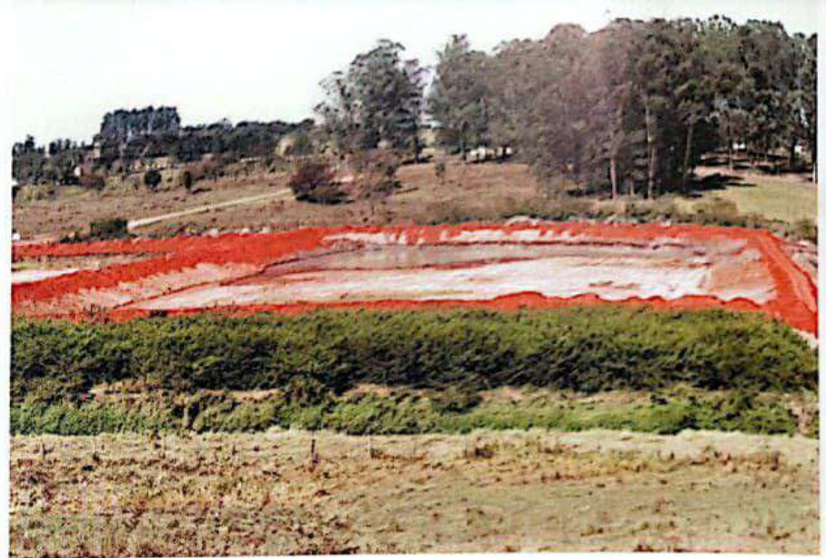
... Estação de Tratamento de Esgoto.
