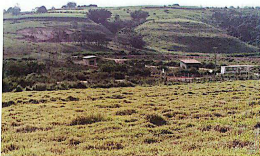
Fase atual da Estação de Tratamento de Esgoto.
