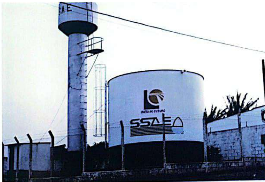
Reservatório Nicola Gola.
