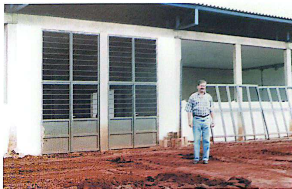
Lito visita obras de construção do prédio.
