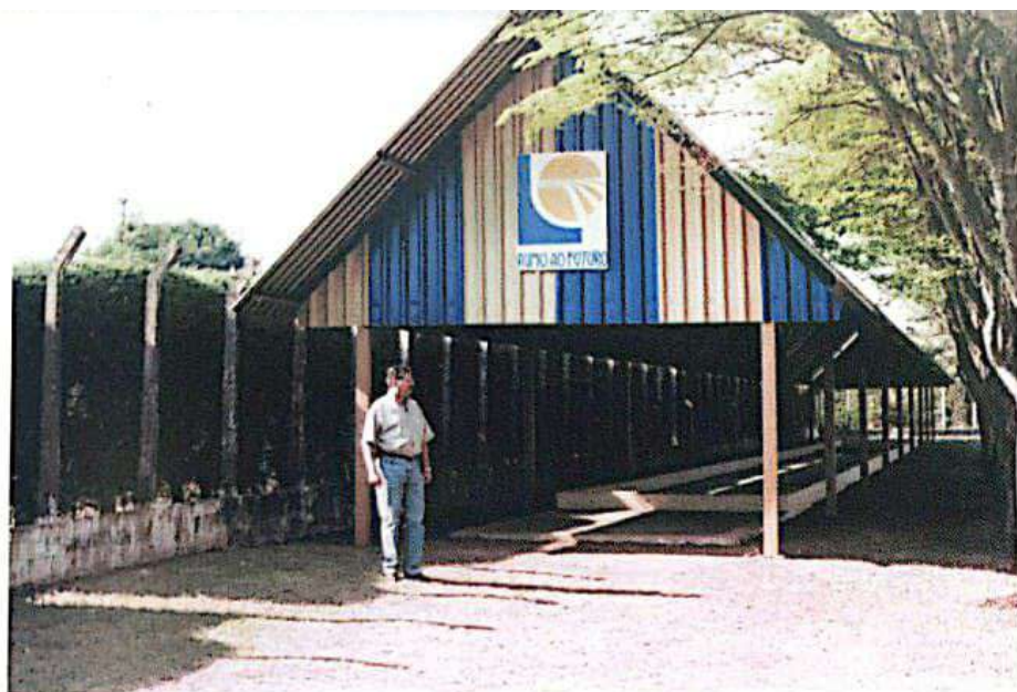
Construção da Quadra de Malha na CME.
