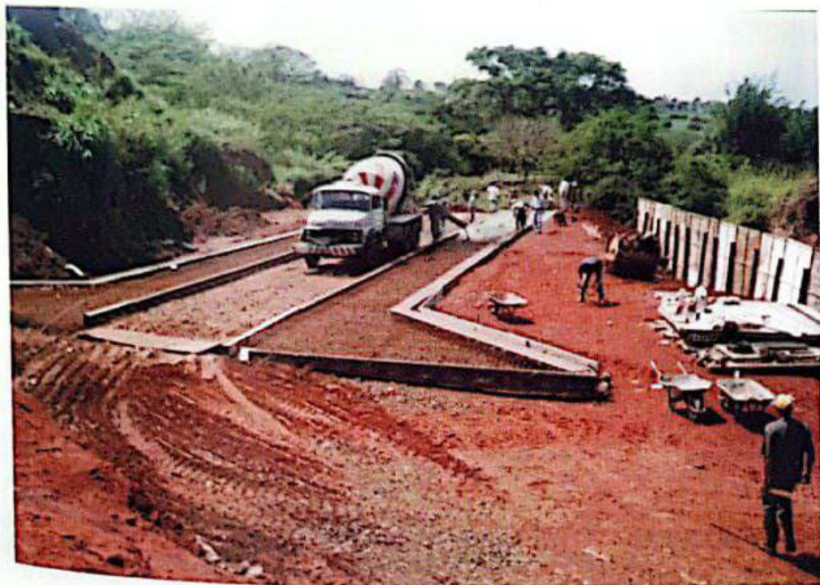
Construção da passagem e galerias do bairro Bela Vista.
