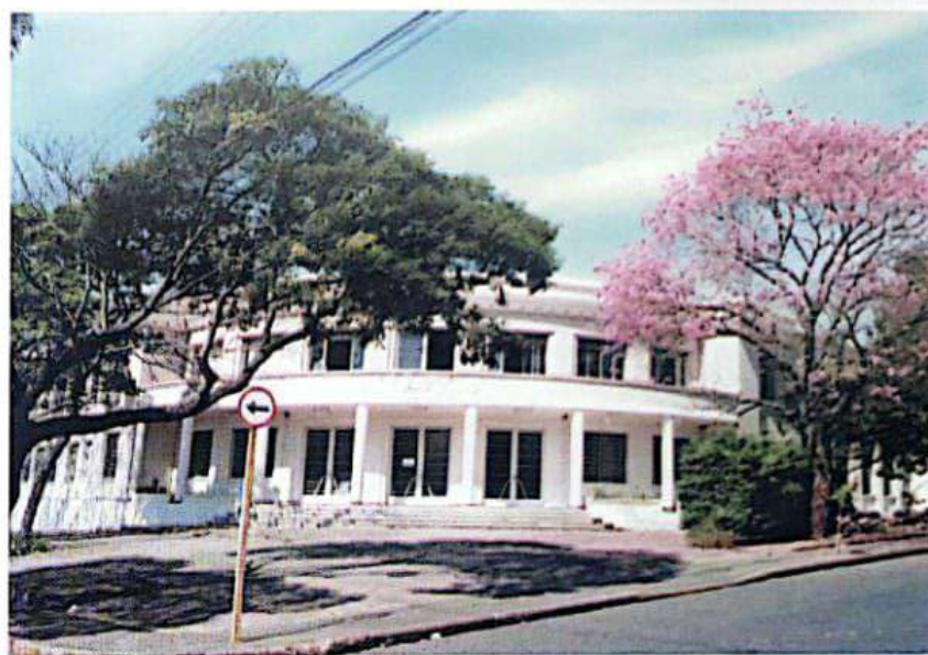
Reforma, construção de quadra coberta e biblioteca do Ginásio.
