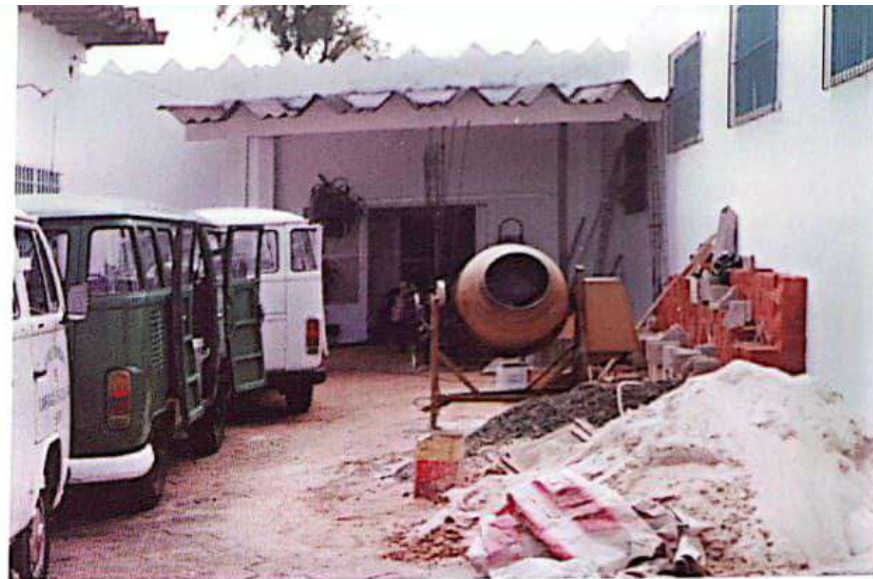
Ampliação e construção de Câmara Fria na Merenda Escolar.
