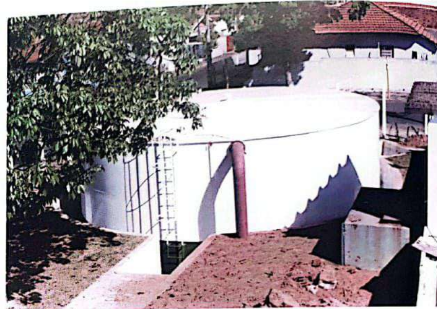
Construção de mais um reservatório.
