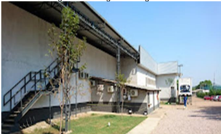
Figura 5. Vista geral do frigorífico.
